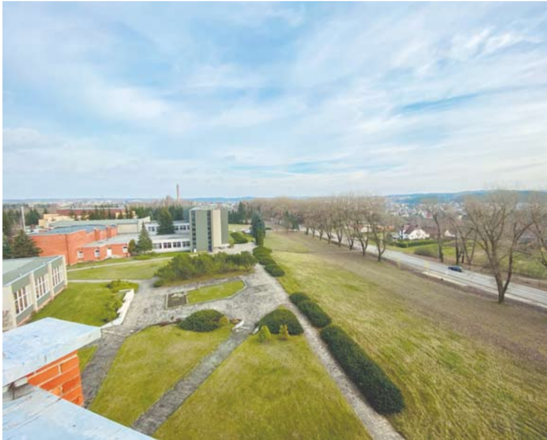
Nuo šiuo metu remontuojamo bendrabučio stogo atsiveria įstabi Anykščių miesto panorama.
